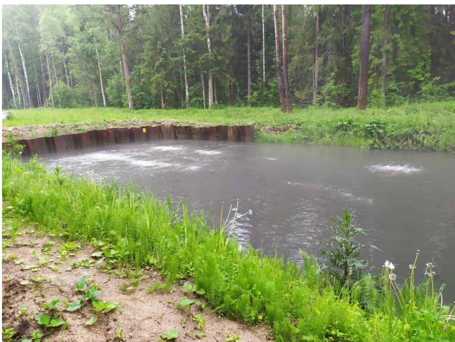
Рис. Рисунок 1 - Первая ступень доочистки – пруд с аэрацией
