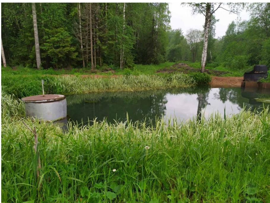
Рис. Рисунок 3 - Третья ступень доочистки – пруд естественным отстаиванием воды
