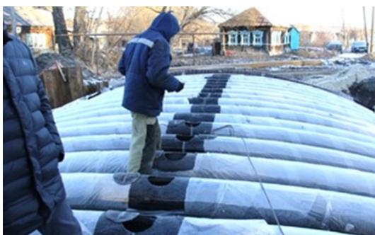
Рис. 1. Работы перед бетонированием арочных элементов
