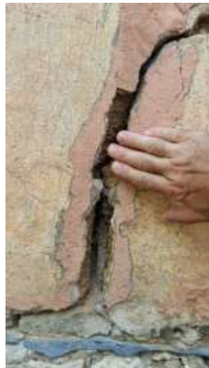
Рис. 12. Трещины в трансформаторной будке. Фото 2025 г.
