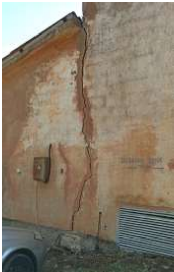
Рис. 12. Трещины в трансформаторной будке. Фото 2025 г.
