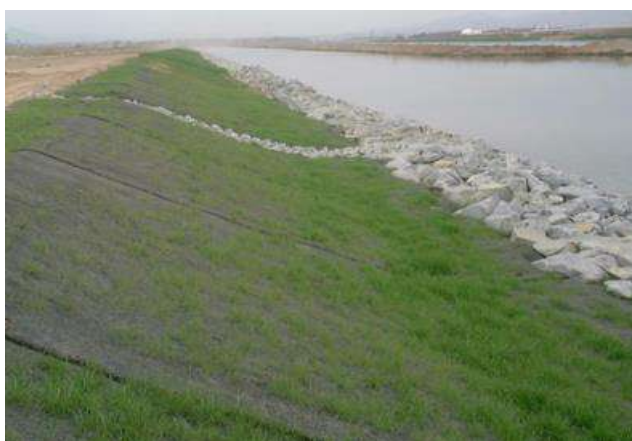
Рис. 2 Укрепление откосов водных объектов геоматом с биологическим типом укрепления (посевом трав)
