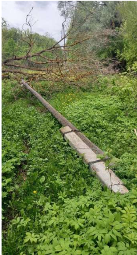
Рис. 1 Разрушение опоры ВЛЭП упавшим деревом
