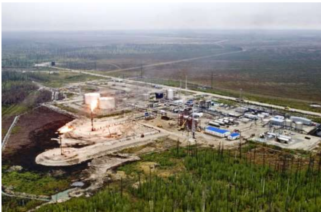
Рис. 5. Факелы сжигания ПНГ Самотлорского месторождения близ г. Нижневартовска с наблюдающимися просадками и обводнением поверхности по периферии насыпей факельных площадок, а также высохшим древостоем.
