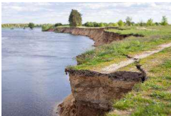
Рис. 1 Обрушение и эрозия неукреплённого откоса
