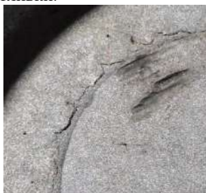
Рис. 5 – Трещины на поверхности отливки
